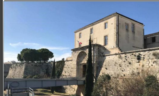
SECURISATION DU MUR D'ENCEINTE
